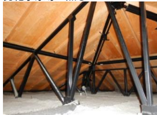
屋根裏点検口の内部
