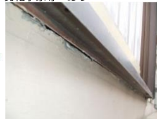
サッシ下の隙間があり、漏水リスクがあった
